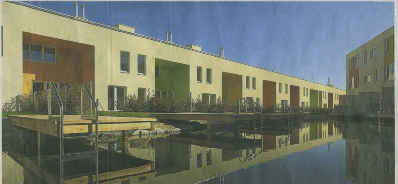
Reihenhausanlage an der Erlaaerstraße in Wien: Wasserzugang vor der Terrassentür.
