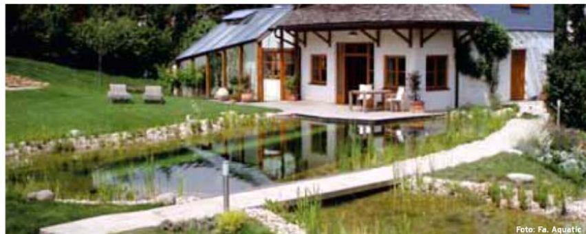
Ob Zierteich oder Badespaß - für schnell Entschlossene wird der Teich noch vor dem Sommer fertig
