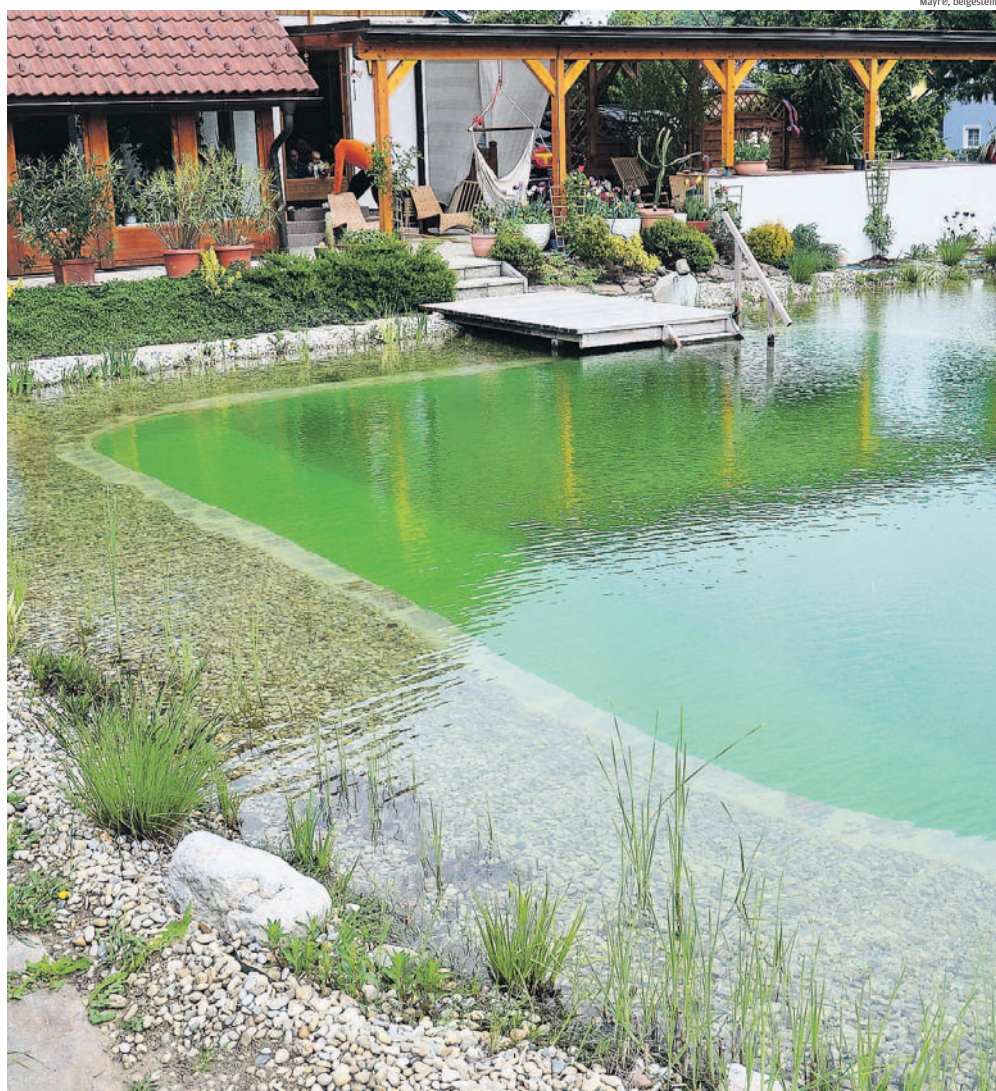
Schwimmteiche benötigen große Regenerationszonen, Naturpools nahezu keine
